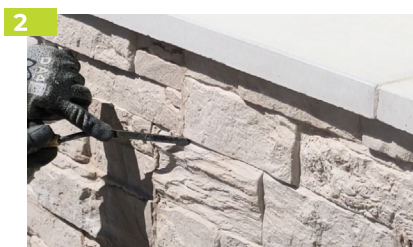
2 Lisser à l'aide d'un fer à joints.
