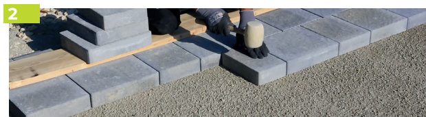
2 Ajuster la position des pavés à l'aide d'un maillet en caoutchouc.
