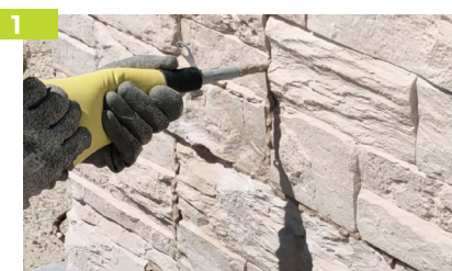
1 Jointer à la poche à joints.
