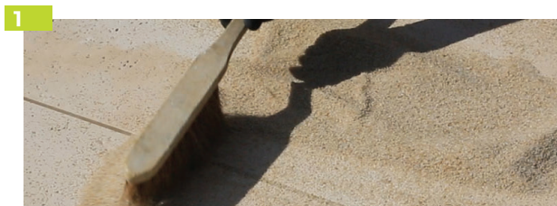
1 Pose sur sable : Procéder au remplissage des joints des dallages au sable (pas d'utilisation de sable polymère).
