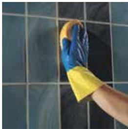
Nettoyage et finition à l'aide d'une éponge en cellulose dure
