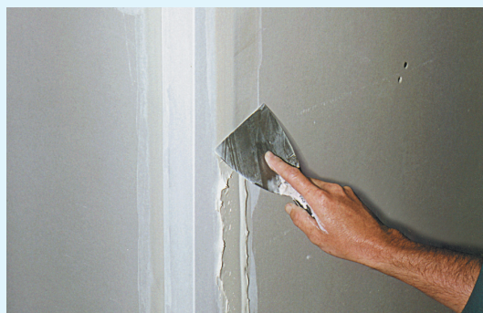
Lissage de l'enduit après pose de la bande Ultraflex (angle sortant)
