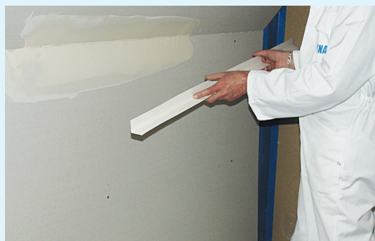
Pose de la bande Ultraflex (angle rentrant)
