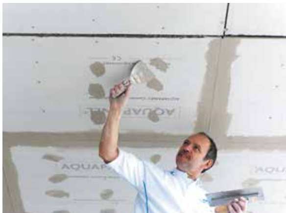
Traitement des têtes de vis
