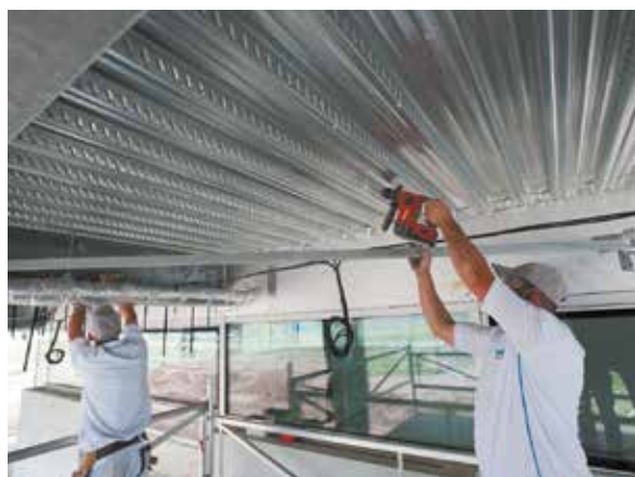
Mise en place des suspentes
