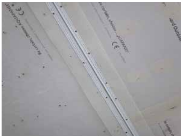
Joint de fractionnement
