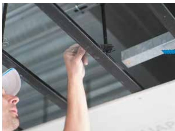
Mise en place des suspentes
