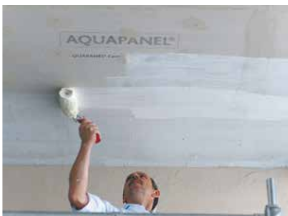
Traitement des têtes de vis
