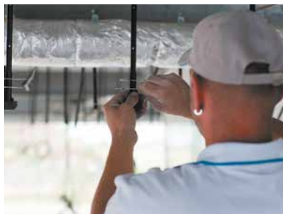
Réglage des suspentes
