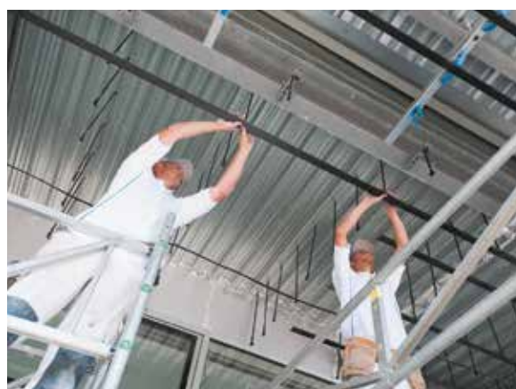
Réglage des suspentes
