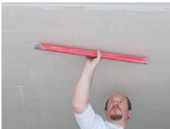
Application de l'enduit d'armature plafond
