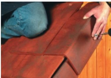
Mise en oeuvre des rives individuelles gauches et droites, posées un rang sur deux et fixées par vis et rondelles d'étanchéité
