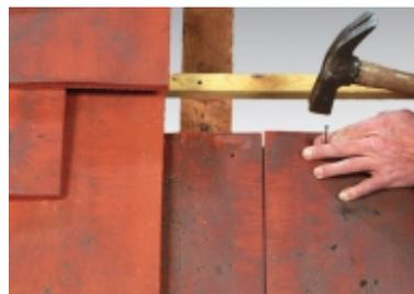
Fixation des tuiles courtes du 1er rang d'égout, par clou.
