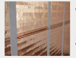
■ Faire la jonction des panneaux HYBRIS grâce à la languette adhésive intégrée.
