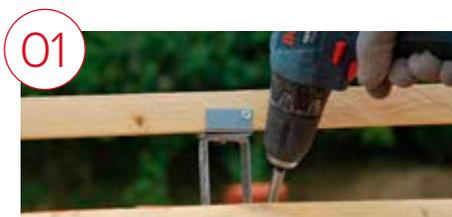
Positionner et fixer l'étrier support de lisse sur la charpente à 5 cm environ au-dessus du dernier rang de tuiles. Installer la rehausse.
