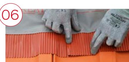
Les raccords doivent être faits en recouvrant les extrémités de 5 cm. A l'extrémité du faîtage ou de l'arêtier, couper le closoir rouleau avec des ciseaux ou un cutter. La chute peut être réutilisée lors d'un prochain chantier.
