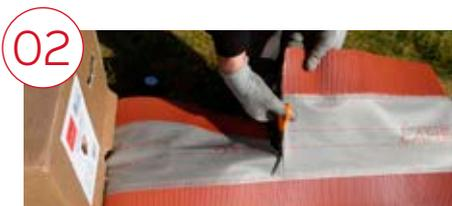
Dans le cas du carton dérouleur, couper une bande de closoir Lahe-First légèrement plus longue que le faîtage et/ou arêtier. Toujours prévoir un recouvrement de 5 cm entre les longueurs. Dans le cas de l'arêtier, dérouler LAHE-FIRST en partant de l'égout. Centrer le closoir sur le bois de lisse à l'aide du marquage central.
