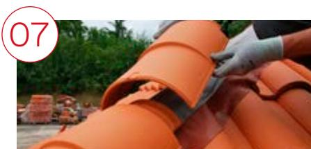
Recouvrir le closoir LAHE-FIRST avec les tuiles faîtières ou les arêtiers. La bande centrale en polypropylène ne doit pas dépasser de la faîtière. Conformément aux DTU de la série 40, le recouvrement des faîtières se fait dans le sens opposé à celui des vents dominants. La fixation des faîtières se fait soit par vis soit à l'aide de clips de faîtière adaptés.
