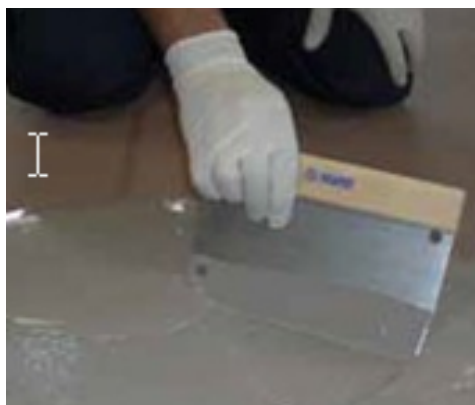
Application de la tère passe de Mapelastick Smart
