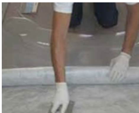
Mise en place de l'armature Mapetex SEL dans la tère passe de Mapelastick Smart
