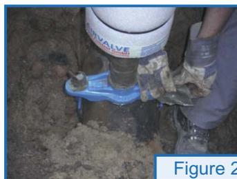
Application de la protection anti-corrosion de la connexion.
