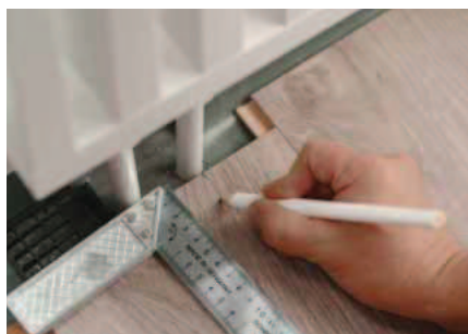
Encadrement de porte et tuyaux de chauffage
