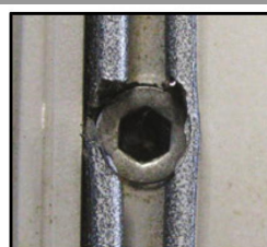
4. Vis Top-Roc mise en place.
