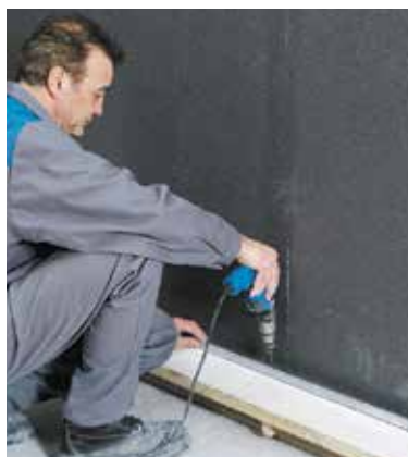
Fixer les rails F47 haut et bas, par chevillage ou pistocellement.
