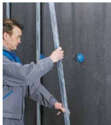
Vérifier l'étanchéité à l'air. Éventuellement, combler avec une mousse PU ou un adhésif aux joints. Puis, clipser la fourrure.
