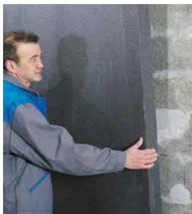
Poser l'isolant Knauf XTherm ULTRA 30, sans colle ni mortier.
