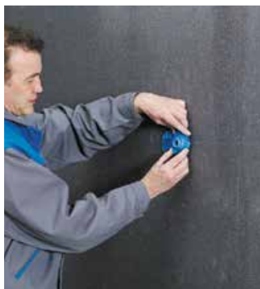
Poser l'isolant Knauf XTherm ULTRA 30, sans colle ni mortier.
