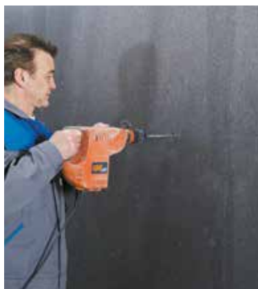
Tracer et percer les implantations des appuis Knauf Easy Click.
