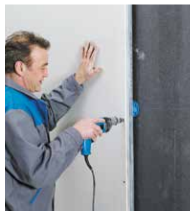
Mettre en place les câbles et conduits. Puis, poser et visser les plaques. Faire les finitions.
