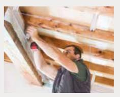
■ Fixer les suspentes sur les chevrons conformément au DTU 25.41. Choisir des suspentes longues à pointes (voir photo ci-dessous).
