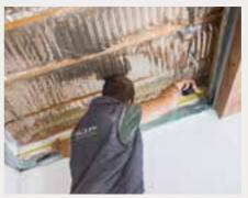
■ Mesurer la distance entre la panne et le mur, pour connaître la dimension de la 2ème couche d'HYBRIS<sub>31</sub> à découper.
