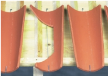
Fixation des tuiles de courant du 1er rang d'égout, par crochets longs à œil Réf. CRCAN.555
