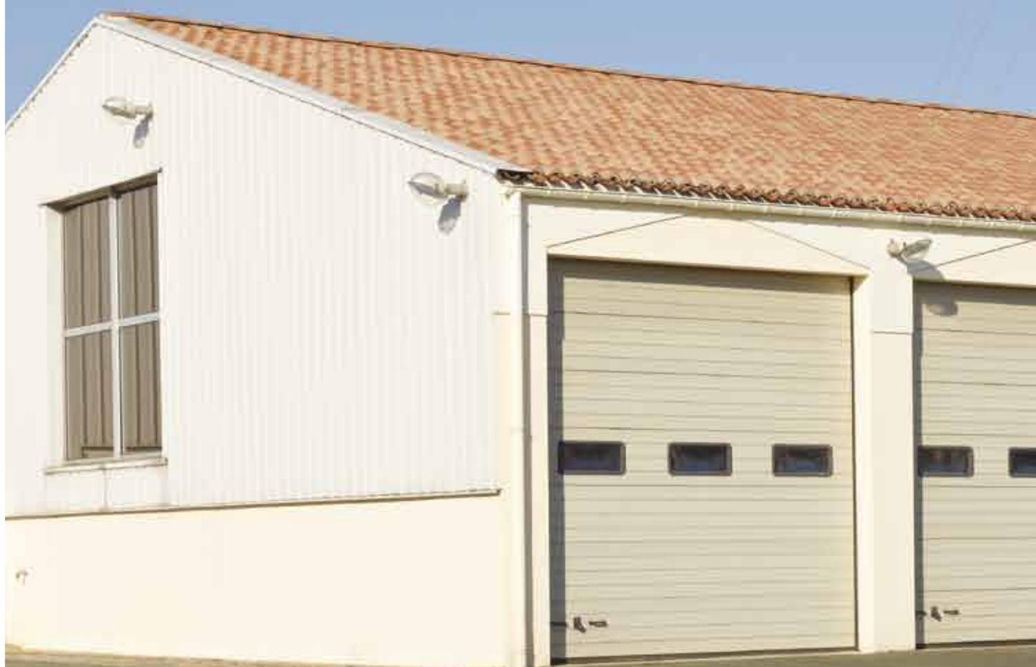
Des solutions **tégula** existent pour les plaques de couverture. Elles agrémentent les toitures dans le respect de la tradition régionale en tuiles canal. De plus, elles renforcent la résistance et l'étanchéité de la toiture.
