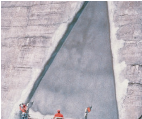
Exemple d'application de Mapelastick Zero par projection sur un barrage
