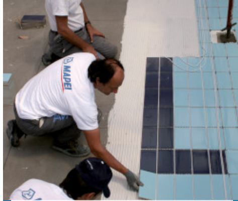
Pose de carrelage céramique sur Mapelastick Zero dans une piscine
