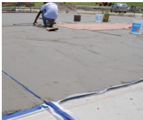
Imperméabilisation des chapes avec Mapelastic Zero et Mapeband
