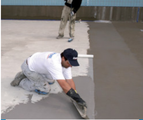
Imperméabilisation d'une piscine avec Mapelastick Zero
