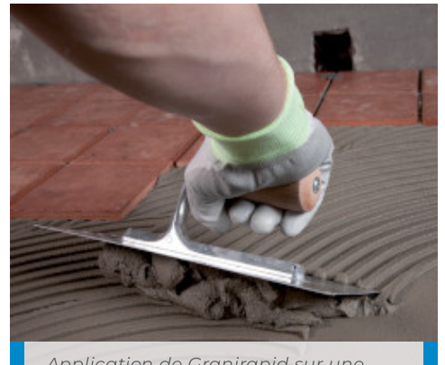
Application de Granirapid sur une terrasse imperméabilisée avec Mapelastick Zero
