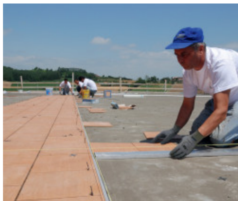
Pose de carrelage avec Kerabond + Isolastic
