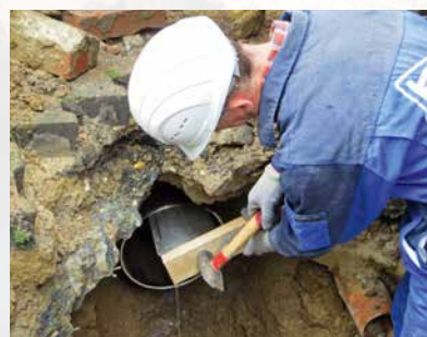
Raccordement d'un tuyau en béton à fond plat avec un tube PVC CONNEX à l'aide de l'adaptateur BI-Funke
