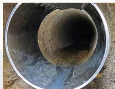
Raccordement d'un tuyau en béton à fond plat avec un tube PVC CONNEX à l'aide de l'adaptateur BI-Funke
