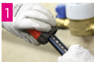
1 Préparation du tuyau
