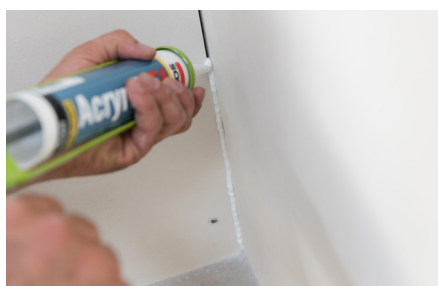
Traitement des angles et points singuliers
