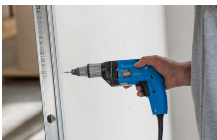
Vissage des plaques Knauf HydroProof®
