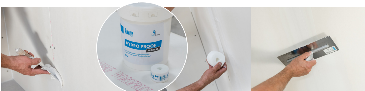
Enduisage et mise en place de la bande à joint Knauf HydroProof® avec l'enduit prêt à l'emploi Knauf Proplak® HydroProof® : facile à mettre en œuvre, pour un rendu très blanc et une finition parfaite.
