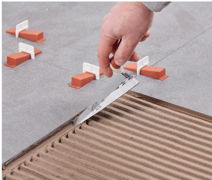
Système autonivelant composé de sa base et son coin permettant d'assurer la bonne mise à niveau des carreaux afin d'obtenir une planéité parfaite. Système capable de niveler les carreaux les plus lourds.
