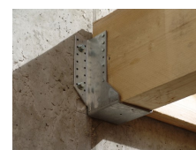
Fixation de structure bois
