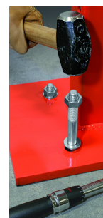
Fixation de structure métallique
