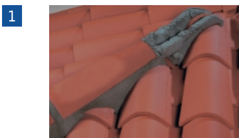
1 Après coupe des tuiles d'approche, mise en oeuvre des tuiles Canal 230-50, utilisation de mortier (D.T.U. 40.22 art. 2.4).
