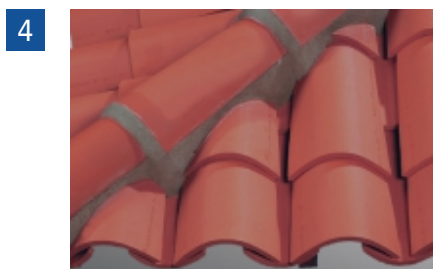
4 Tuile Canal 230-50 scellé au mortier (D.T.U. 40.22 art. 2.4).
