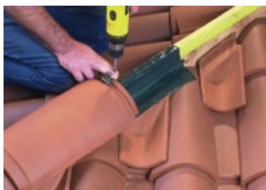
Fixation des sablières par vis et rondelle d'étanchéité.
