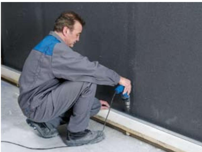
6. Vérifier l'étanchéité à l'air. Eventuellement, combler avec une mousse PU ou un adhésif aux joints. Puis, clipser la fourrure.
