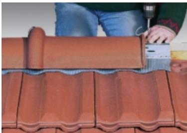
Après mise en place du closoir ventilé, les faîtières sont fixées par crochet adapté au modèle, vissé dans la lisse de rehausse.
